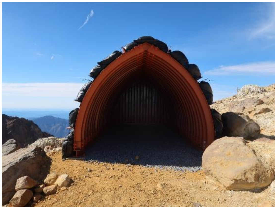
② まごころの塔～大岩の間にシェルター（鋼製） 1 基新設【R4 年度完成】
